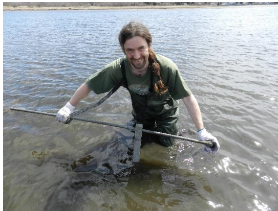
Rémi Donelle qui installe les ancrages vissés
